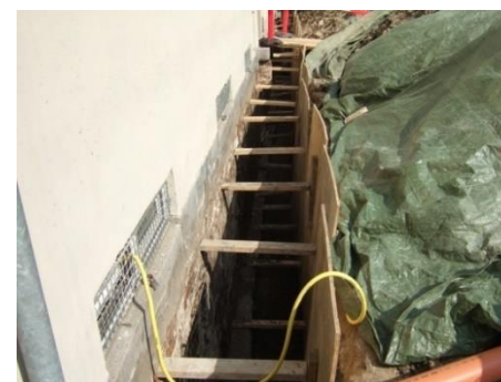
Eksempel på opgravning for udvendig fugtsikring og dræn
