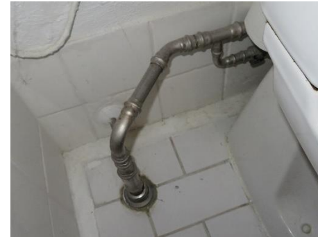
Vandinstallation i badeværelse
