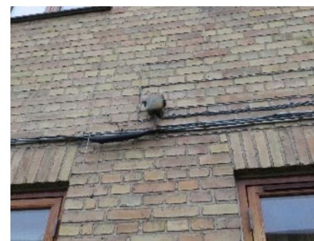
Kabler på facaden
