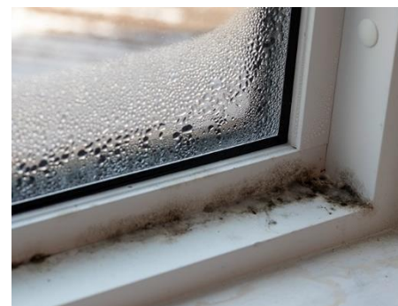
Kondens dannes når fugtig luft møder kolde overflader
