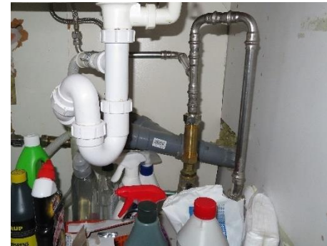
Vandinstallation i køkken
