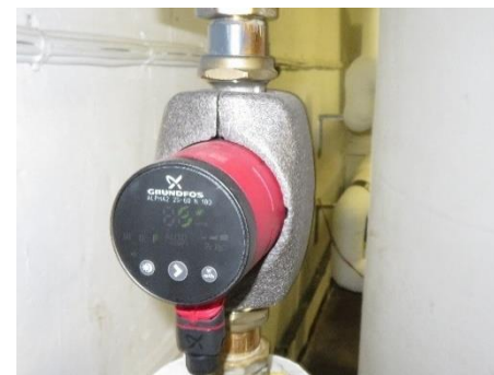
Cirkulationspumpe
