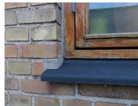
Fuge mellem karm og murværk
