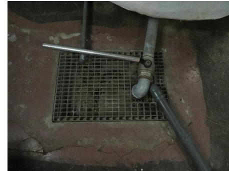
Kloakbrønd i gård
