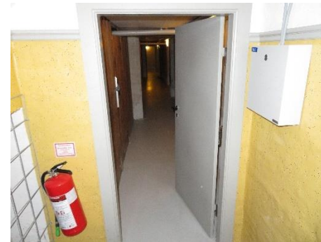
Dør mellem trapperum og kælder
