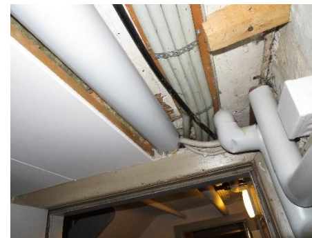
Isoleringsplader monteret i loftet af kælderen
