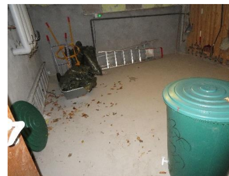
Kældergulv med epoxybehandling
