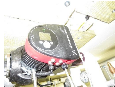
Cirkulationspumpe
