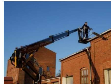
Lift til arbejder på facade eller tag
