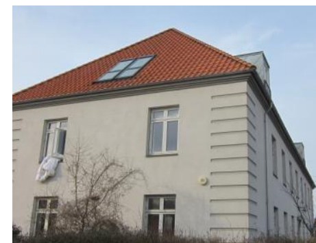
Eksempel på færdig overflade med fremrykkede vinduer
