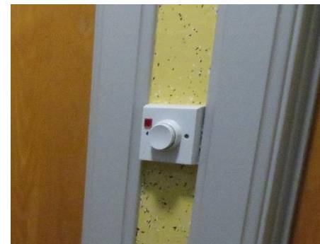
Lysinstallation i opgang. Columbustryk ikke i brug.
