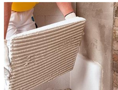
Fuldlimede isoleringsplader til indvendig efterisolering
